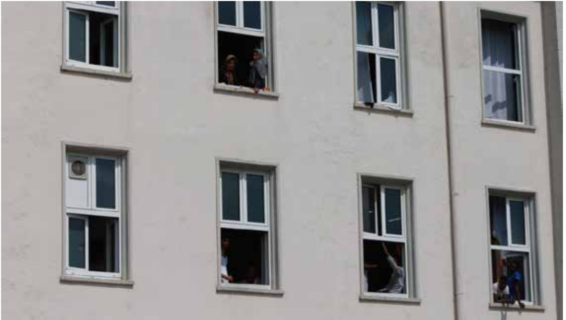
Gebäude der Erstaufnahmeeinrichtung im Sommer © Fabian Boist
