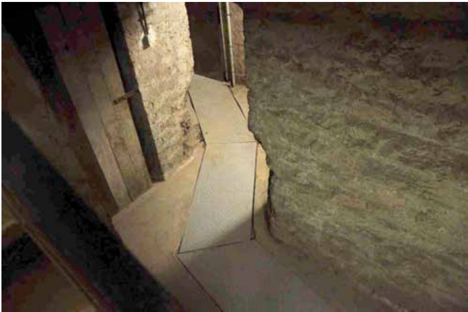
Flur im Keller des Mehrgenerationenhauses in Trier. Bild von Calin Cruse
